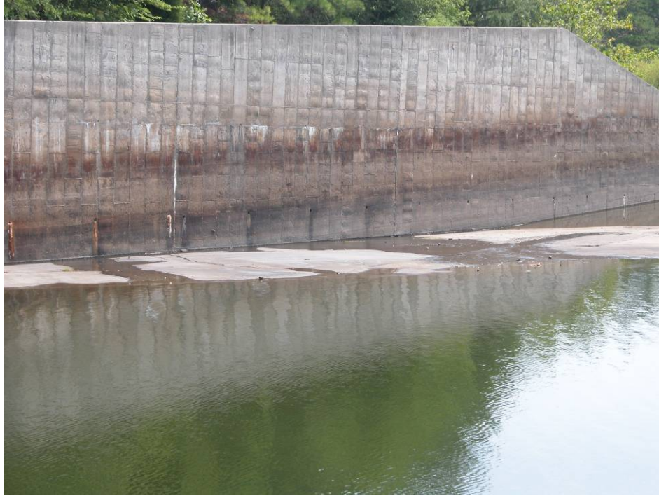
17. Main Dam – Spillway left wall (August 5, 2008)..
