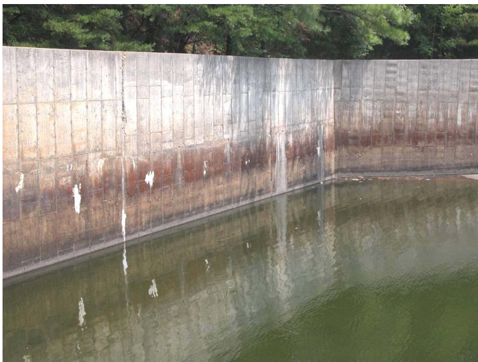
16. Main Dam – Spillway left wall (August 5, 2008).
