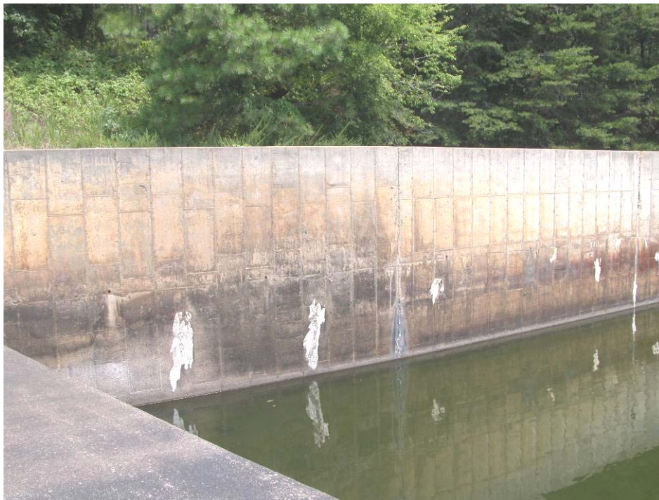
15. Main Dam – Spillway left wall (August 5, 2008).
