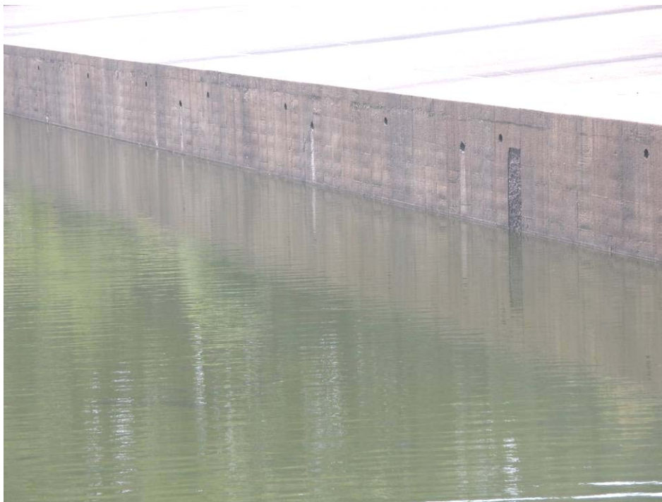
12. Main Dam – Drop wall (August 5, 2008).
